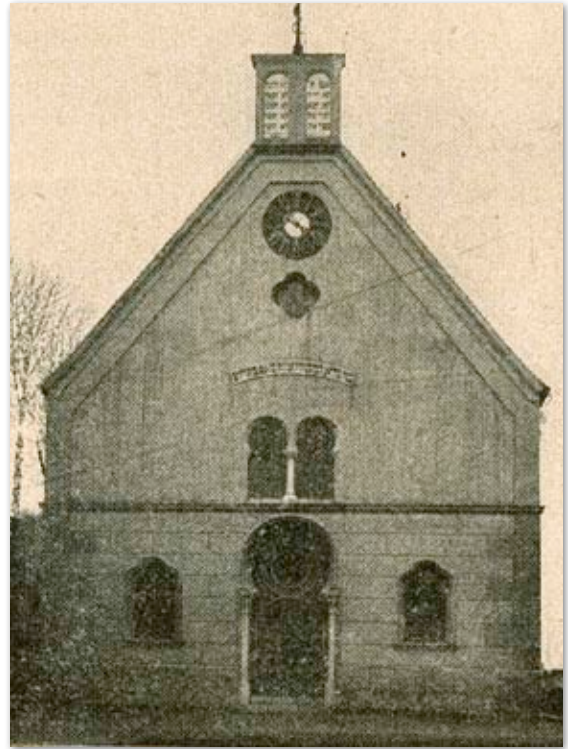
Westfassade der Synagoge, Foto vor 1911; aus: Israel Lammfromm, 1911.
